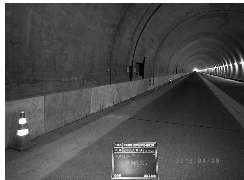
図-4 立壁設置完了写真
