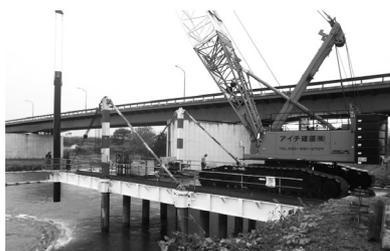
図-3 LIBRA工法（栈橋先行・杭打込状況）
