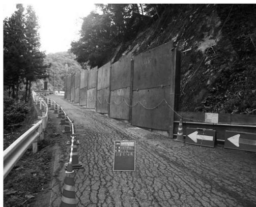
図-4 仮設防護柵設置
