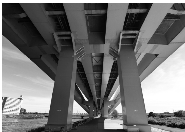
図-1 平井工区の隅角部補強
