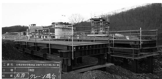
図-3 クレーン構台
