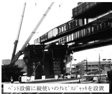
図-3 手延べ機のたわみ取り設備
