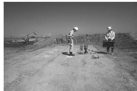
図-3 試験盛土現場密度測定状況
