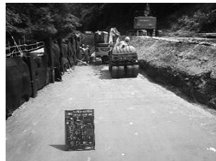
図-3 仮緊張作業 図-4 背面埋戻し作業
