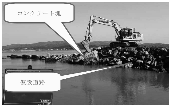
図-2 コンクリート塊撤去
