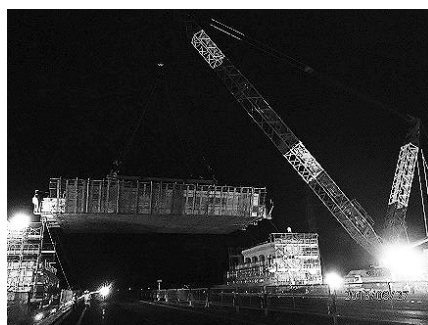
図-5 一括架設状況
