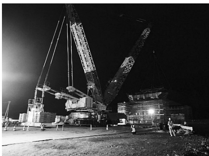
図-3 750t吊オールテレーンクレーン
