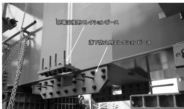
図-4 落下防止用エレクションピース
