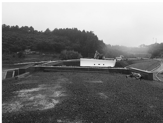
図-1 現場施工前
