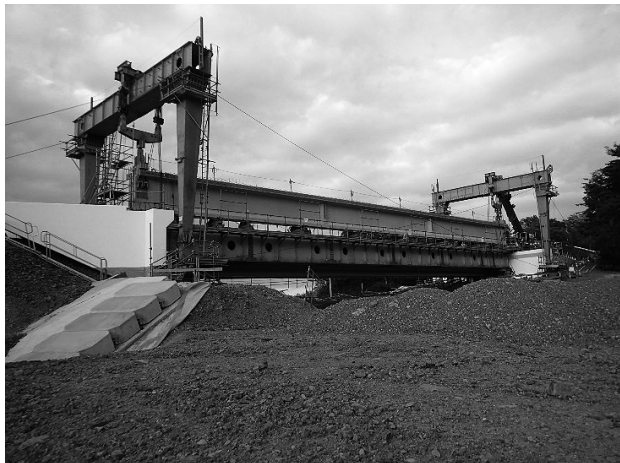
図-2 主桁架設状況
