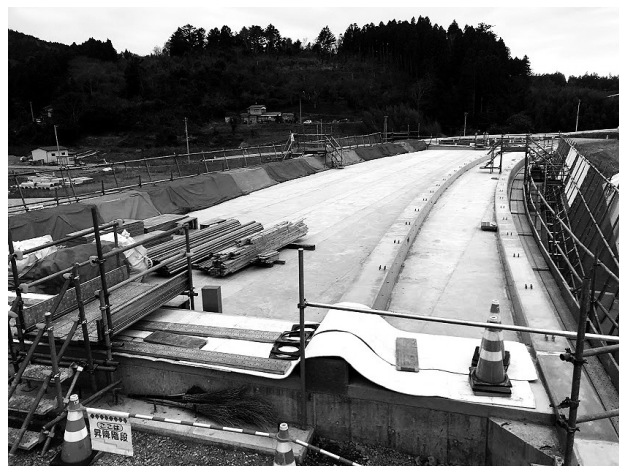
図-3 現在の長清水橋の状況
