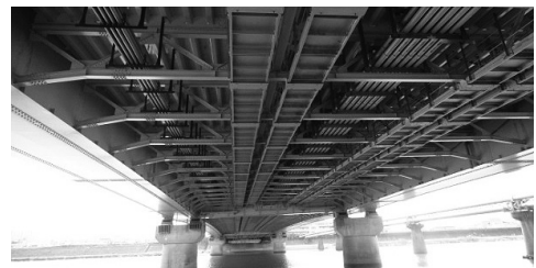
図-2 阪堺大橋右岸より下面を望む
