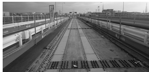
図-3 固定規制状況
