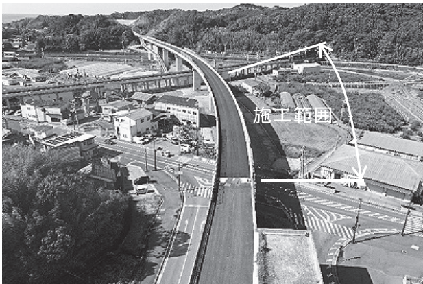
図-1 芳養高架橋（※1）
