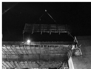
図-5 朝顔防護の面組架設
