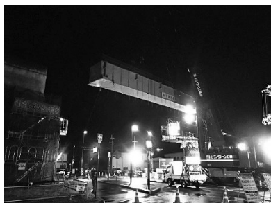
図-4 3ブロック一括架設
