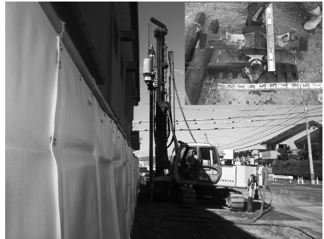
図-3 TSC工法の施工状況と攪拌機 \phi 800
