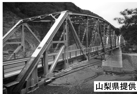
図-3 施工完了写真
