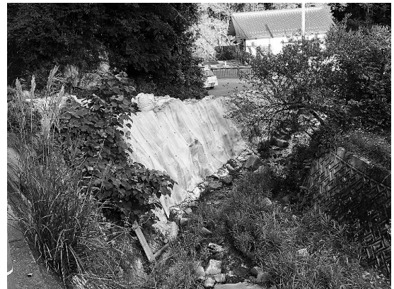
図-5 補修完了 (R1年9月)
