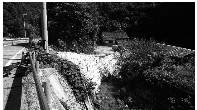
図-2 応急復旧完了時 (H30年9月)
