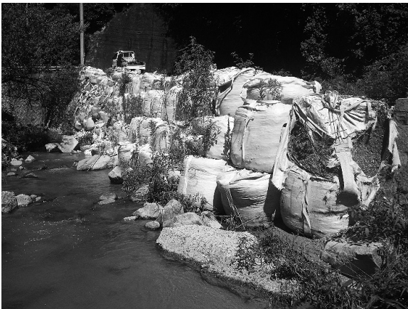
図-3 損傷状況 (R1年9月)
