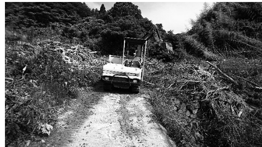
図-5 A箇所施工状況
