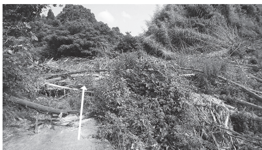
図-1 工事箇所A 着手前（道路）
