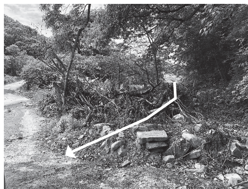
図-2 工事箇所B 着手前（河川上流）
