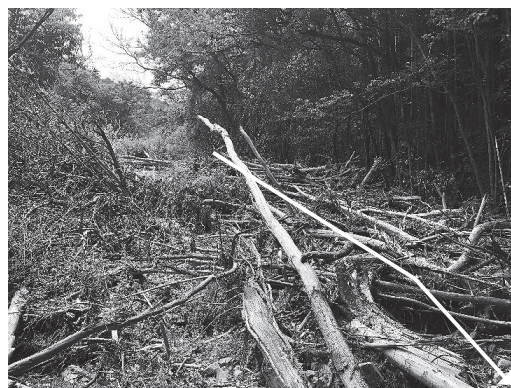
図-3 工事箇所C 着手前（河川下流）
