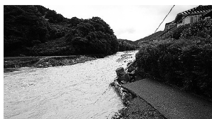
図-2 災害発生時
