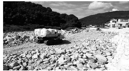
図-5 大型土嚢場内運搬
