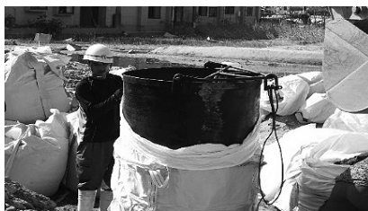
図-4 大型土嚢作成
