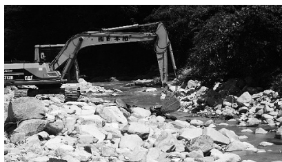
図-3 水道掘削
