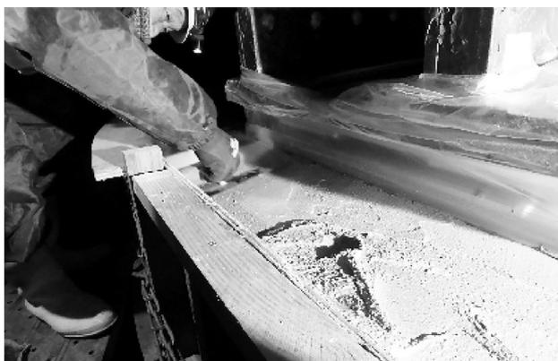
図-10 タンピング、表面再仕上げ状況
