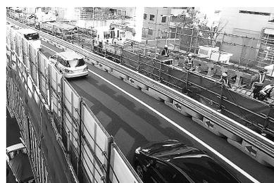
図-7 固定規制と防護状
