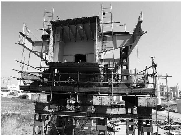
図-9 ベント上のずれ止め
