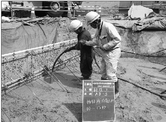
図-6 10～15秒間締固め実施状況
