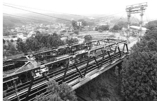
図-7 落とし込み架設状況
