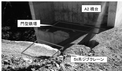
**図-3** ジブクレーンの施工位置
