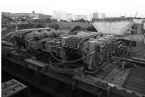
図-7 駆動式シンクロジャッキ
