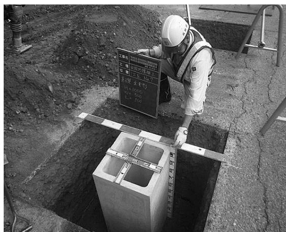
図-1 二次製品枠設置
