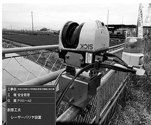
図-3 レーザーバリア警報監視システム
