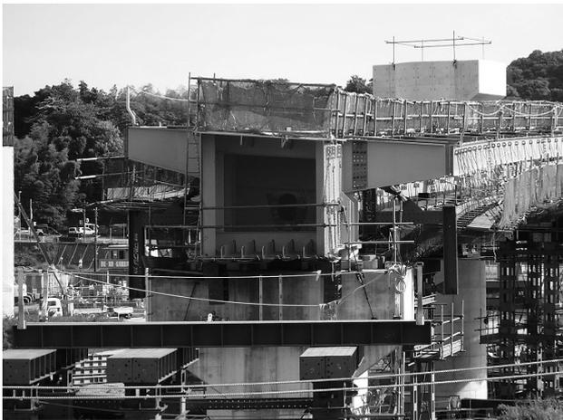
図-8 支点上のずれ止め
