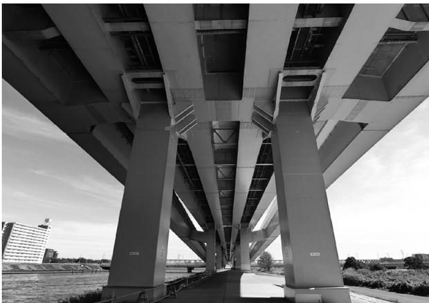
図-1 平井工区の隅角部補強
