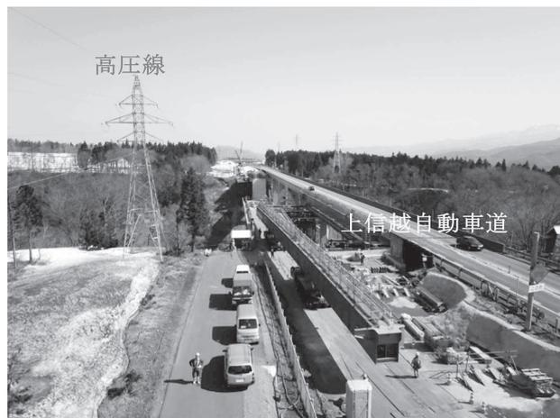
図-2 A1側 側径間架設状況
