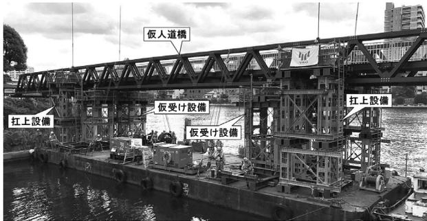
図-8 扛上設備と仮受け設備
