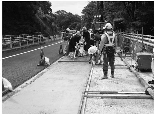
図-5 コンクリート打設状況
