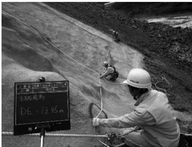
図-2 法面上での巻尺測量
