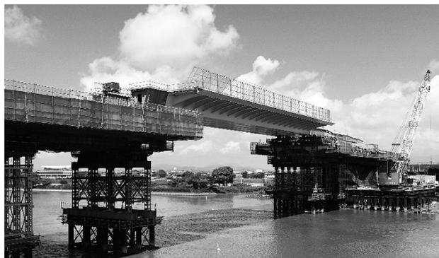
図-8 送り出し架設完了
