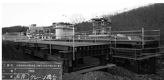
図-3 クレーン構台
