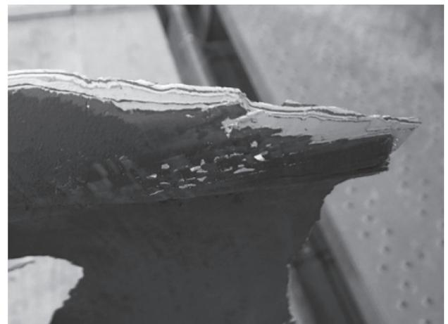
図-9 「IH工法」で除去した塗膜の状態
