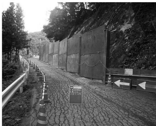
図-4 仮設防護柵設置
