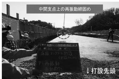
図-5 打設進捗とあとタンピング施工位置関係
