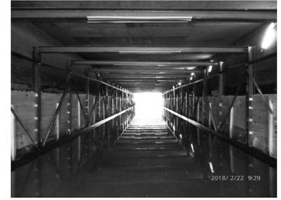
図-10 H鋼横矢板土留め完了
