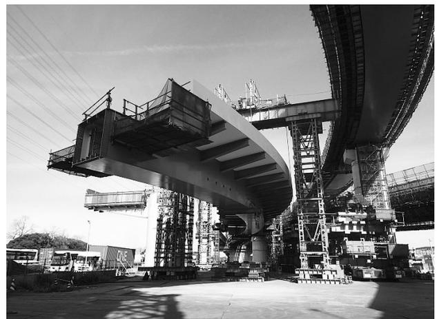
図-4 地組桁吊上げ
