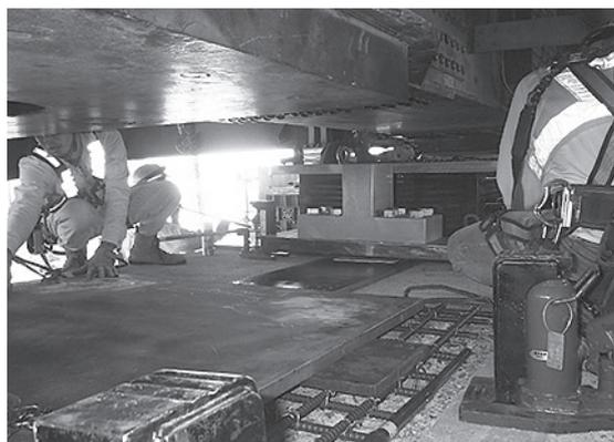
図-4 新設支承引込み状況
