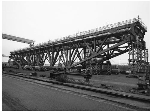
図-2 工場仮組立完了時全景
