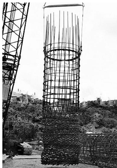
図-2 鉄筋かごの座屈事例①
