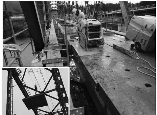
図-8 床版切断・撤去状況
