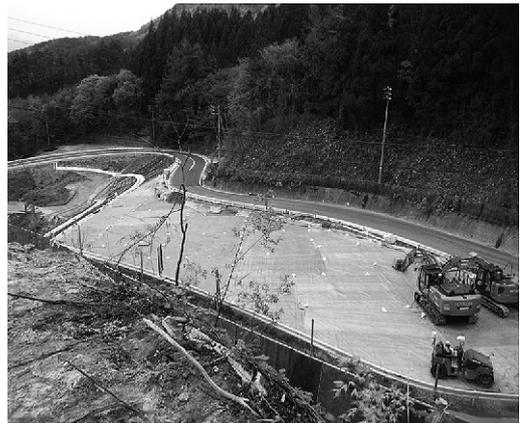
図-3 盛土工施工箇所シート養生
