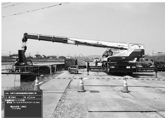
図-3 架空線下継ぎ矢板圧入状況
