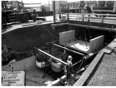
図-11 U型水路吊降ろし状況
