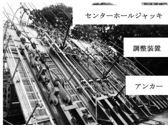
図-5 鉄塔調整装置 (A1)
