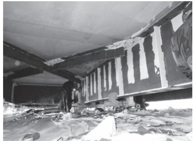
図-8 「IH工法」による塗膜除去状況
