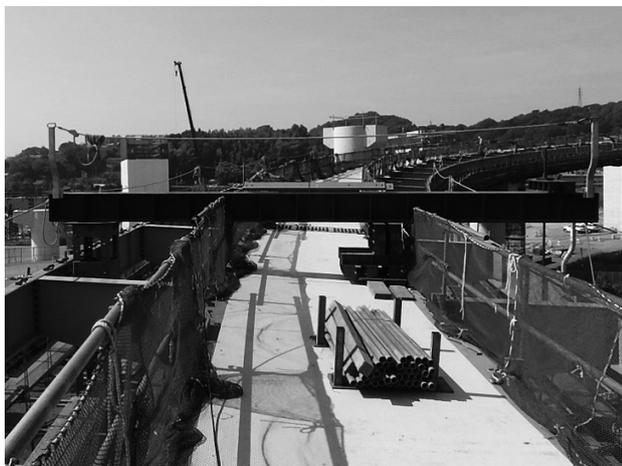
図-5 桁の倒れ抑制設備
