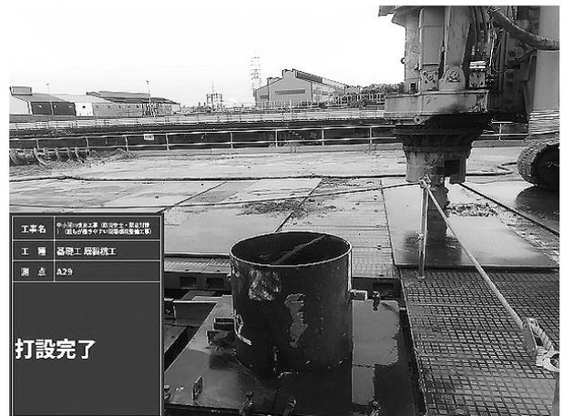
図-6 定規鉄板設置状況
