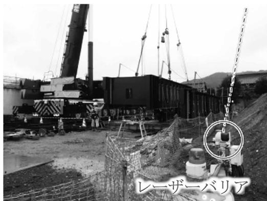
**図-4** レーザーバリアシステム
