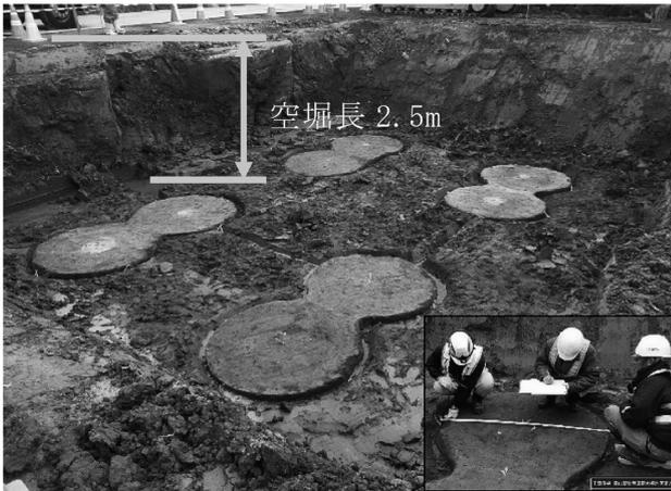
図-2 RMP-MST工法 杭頭出来形確認状況
