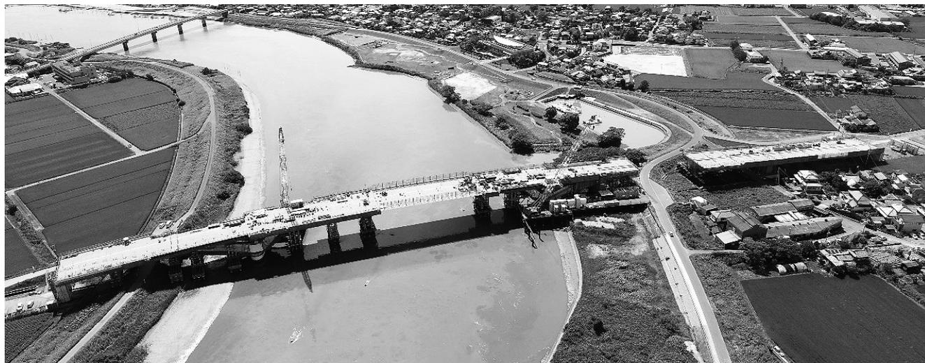
図-9 送り出し架設完了時（全景）
