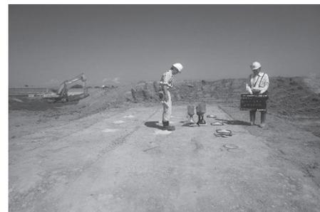
図-3 試験盛土現場密度測定状況
