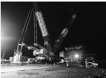
図-3 750t吊オールテレーンクレーン
