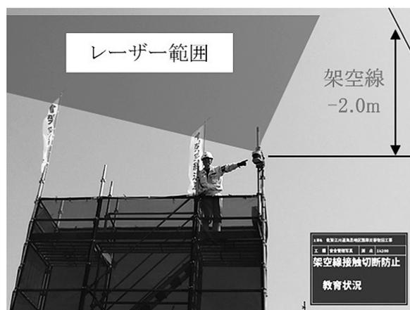
図-5 『レーザーバリアシステム』設置
