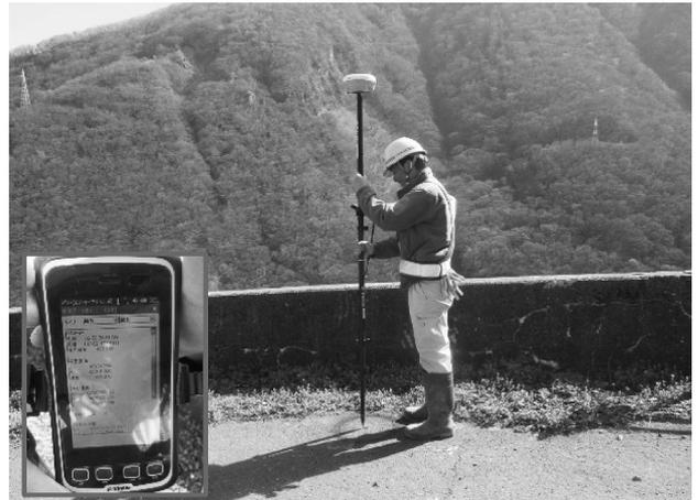
図-3 GNSSによる基準点の点検
