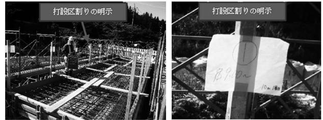
図-9 打設区割りの明示状況
