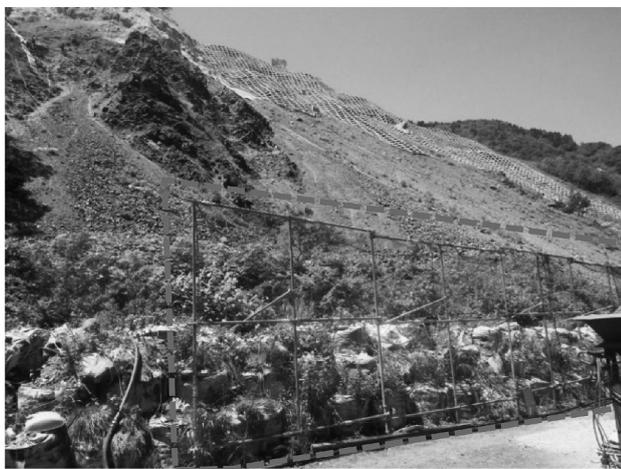
図-8 仮設落石防護柵
