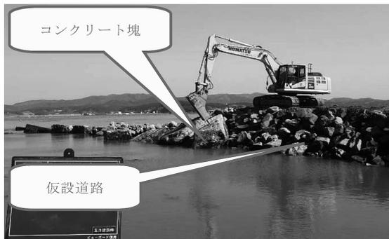
図-2 コンクリート塊撤去
