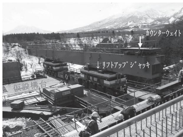
図-4 A2側側径間架設状況
