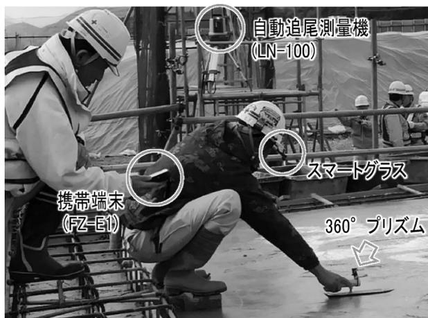
図-2 「コテプリ」を用いた均し作業状況
