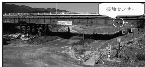
図-4 接触防止センサー
