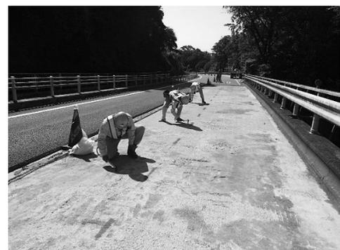
図-1 床版上面打音検査状況
