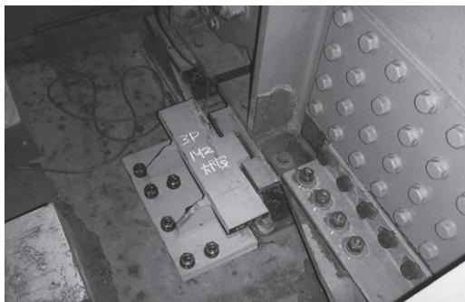
図-11 移動制限装置設置状況
