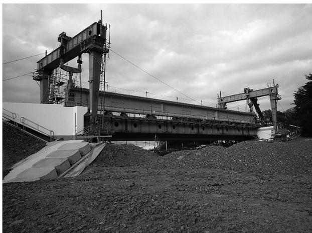
図-2 主桁架設状況
