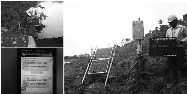
図-2 上流側に水位計の設置
