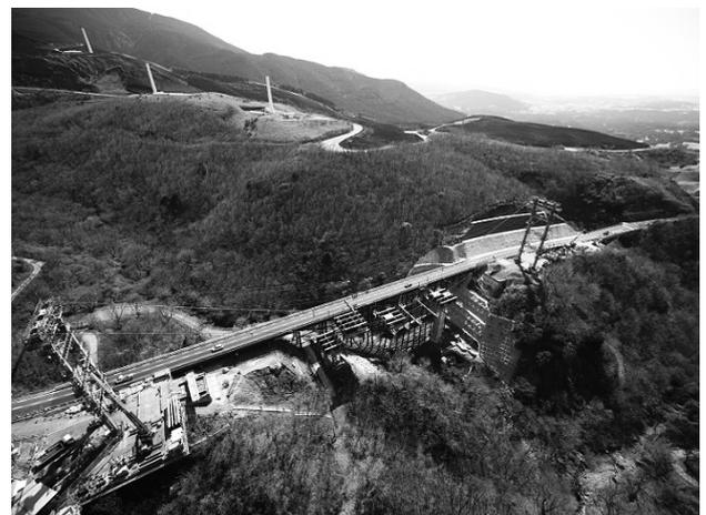
図-7 桁撤去状況
