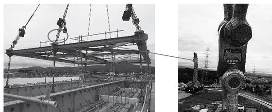
図-4 吊り天秤(荷重計)使用状況
