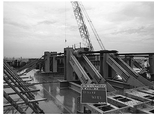
図-6 水平方向引き込み装置
