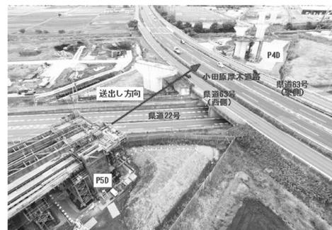
図-1 下り線送り出し前（交差物件条件）
