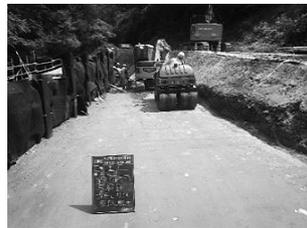
図-4 背面埋戻し作業
