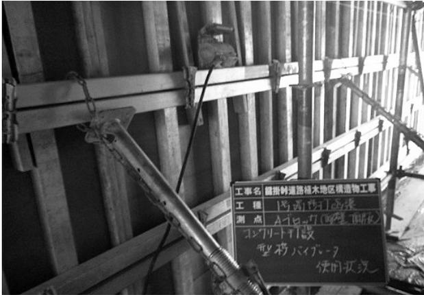
図-11 型枠振動機の使用状況
