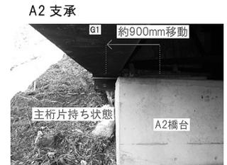
図-2 支点損傷箇所、座屈箇所状況
