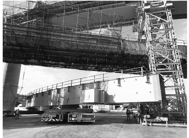
図-3 地組桁ヤード内移動
