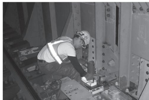
図-13 溶接部切断状況
