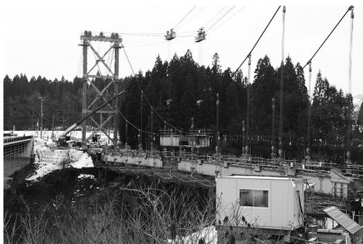
図-11 補剛桁撤去状況
