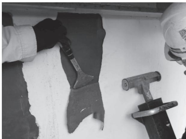
図-4 「IH工法」による塗膜除去状況
