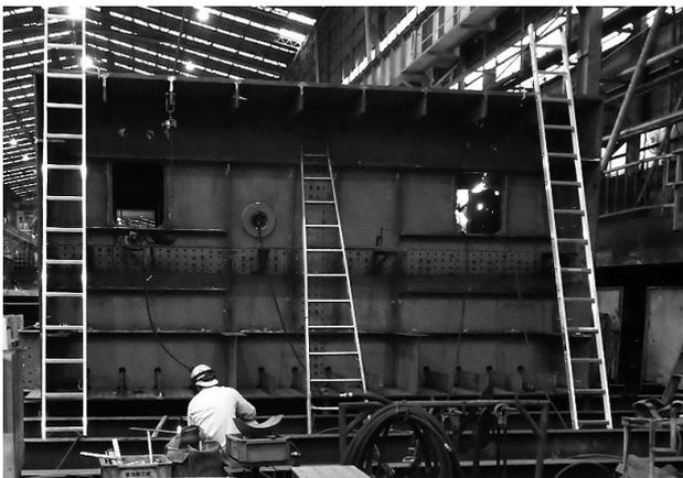
図-3 大型箱桁断面の一体組立
