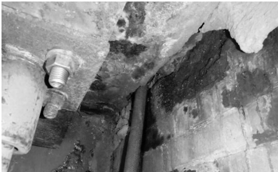
図-4 橋台損傷状況 （伸縮装置下部）
