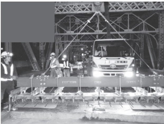
図-7 伸縮装置据付（パネル化）
