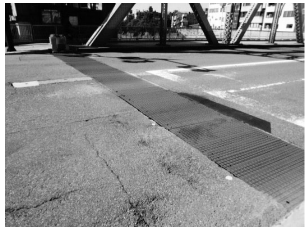
図-5 特注覆工板（昼間時交通開放）
