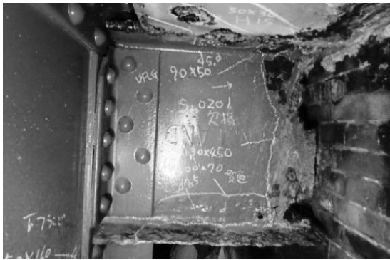
図-3 端縦桁の著しい腐食 （伸縮装置からの漏水が原因）
