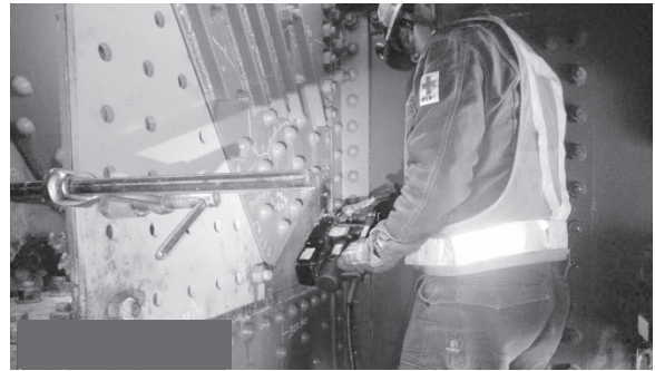
図-8 斜材ガセットプレートリベット撤去 （アトラーで削孔）
