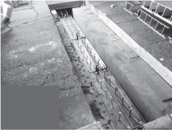
図-6 鋼製型枠設置
