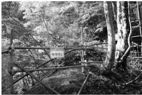
図-11 最終段階（単管柵設置）
