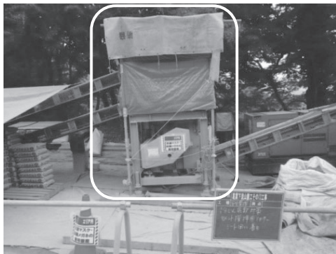
図-4 攪拌部の防塵シート養生
