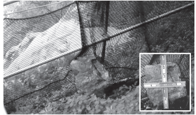
図-9 落石捕捉状況
