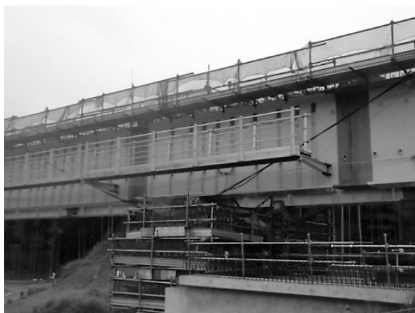
図-8 橋台での桁固定状況
