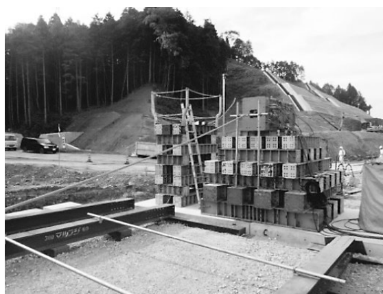
図-7 送り出シヤード後方の逸走防止装置
