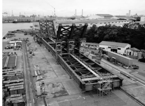
図-4 仮組立状況
