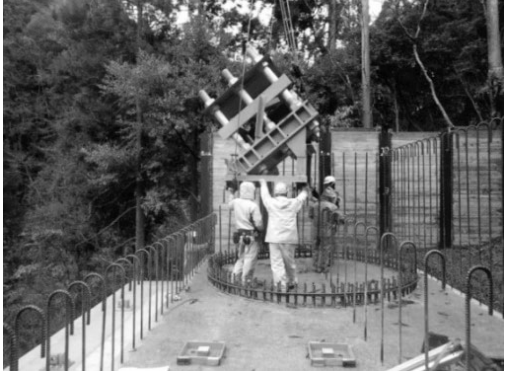
図-5 支承アンカーフレーム据付状況
