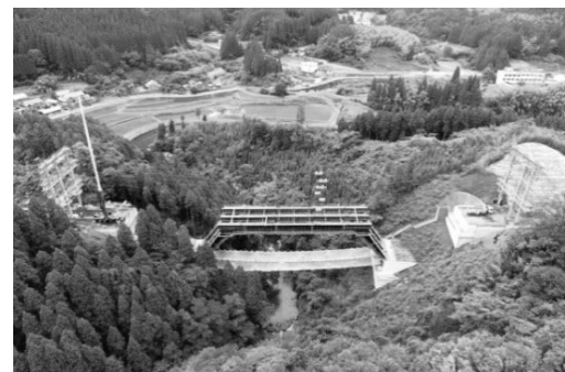
図-10 閉合ブロック架設完了状況
