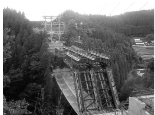
図-9 閉合ブロック架設状況
