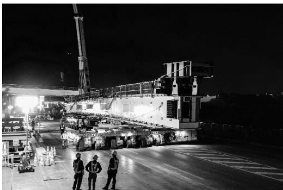
図-8 多軸台車による大ブロック架設桁運搬状況
