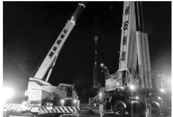
図-7 大型クレーンへのカウンター設置状況
