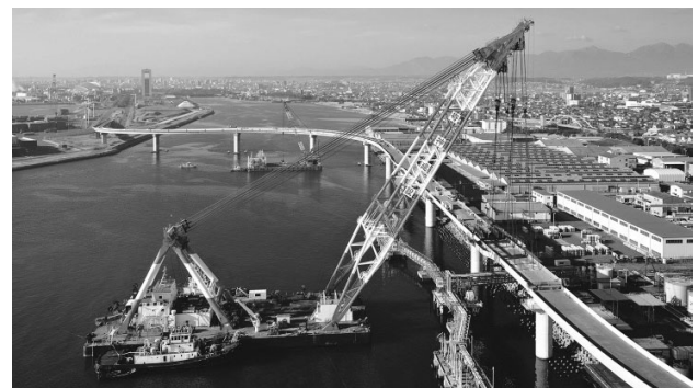
図-6 1400t吊起重機船による大ブロック架設
