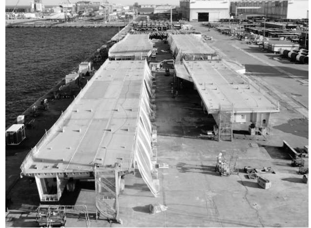
図-5 大ブロックの4ブロック並行地組立状況
