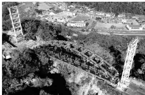
図-1 ケーブルクレーン設備（全景）
