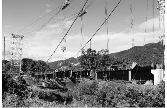
図-8 補剛桁架設状況
