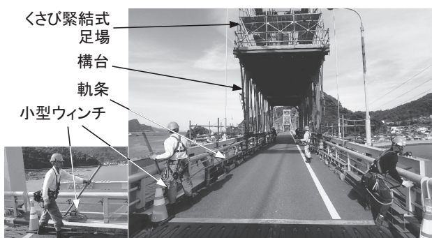
図-4 小型ウィンチによる構台の移動
