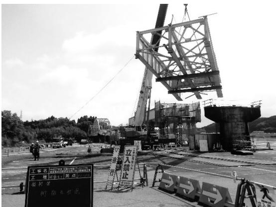
図-7 鉄桁部撤去状況
