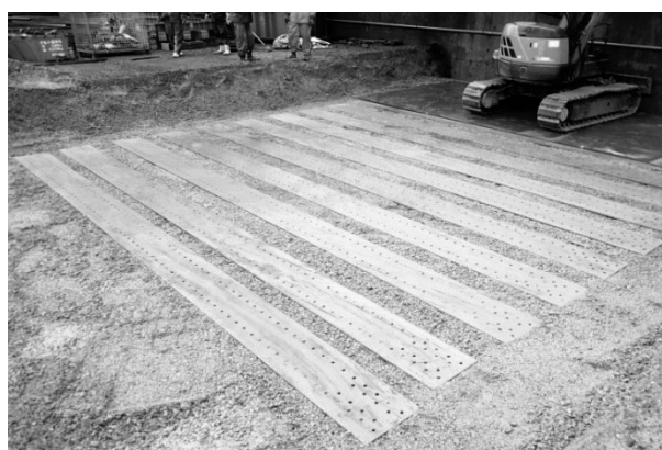
図-11 強化路盤状況
