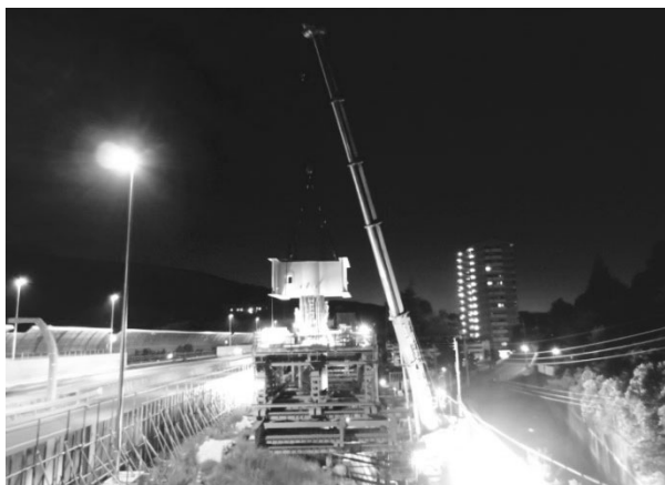
図-5 剛結部鋼製橋脚架設状況
