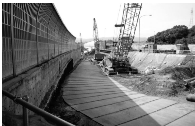
図-9 軌条部ヤード状況
