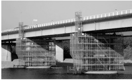
図-8 足場支保工の組換え前
