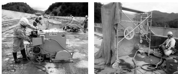
図-3 地覆部・壁高欄部コンクリート切断状況
