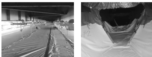
図-4 シート養生状況（下段・中段）
