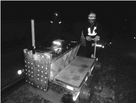
図-5 軽便トロによる運搬状況
