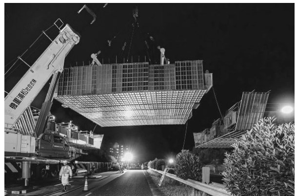
図-5 夜間一括架設状況
