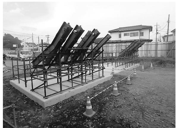
図-8 コンクリートブロック施工状況
