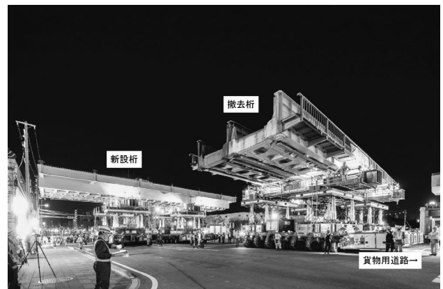
図-8 貨物用道路に移動する既設桁
