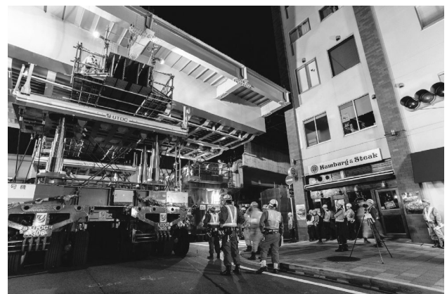
図-9 ビルの直前を走行する新設桁
