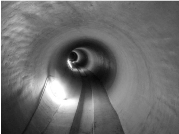
図-5 吹き付け完了
