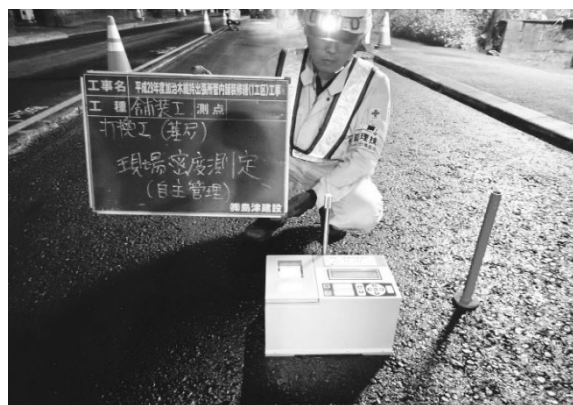
図-6 非破壊測定器による密度測定状況
