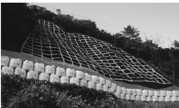
図-2 施工完了直後
