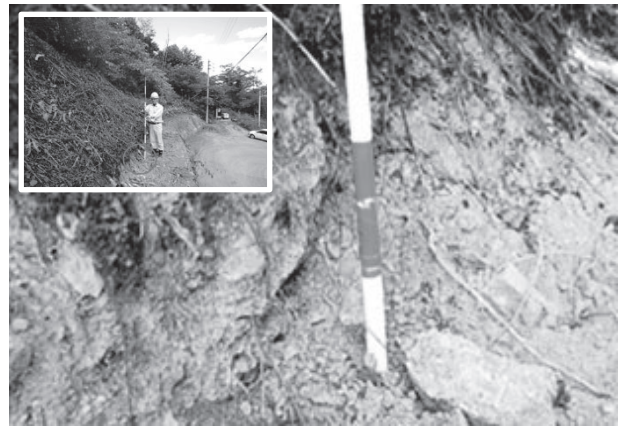
図-1 斜面法尻部の地山状況
