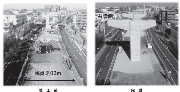
図-2 着工前・完成写真
