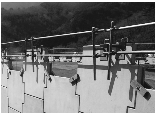
図-3 支柱基礎部をパネルにはめ込む方法で手摺を一体化した転落防止柵
