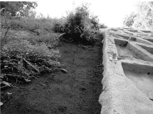
図-3 地山境目基盤材吹付け
