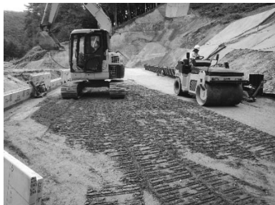
図-5 内部材転圧
