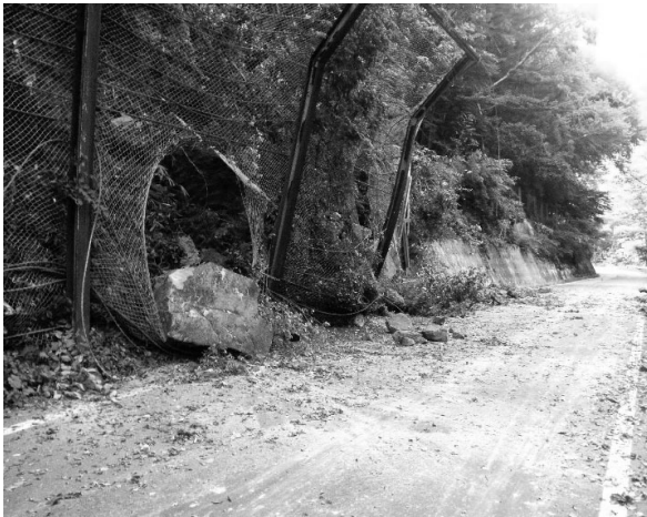
図-1 巨石崩落状況
