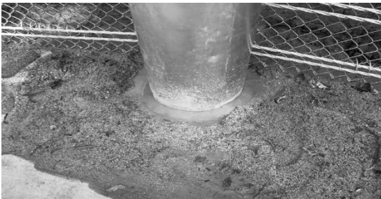
図-4 杭基礎周りモルタル保護
