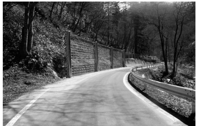
図-6 落石防護柵工竣工
