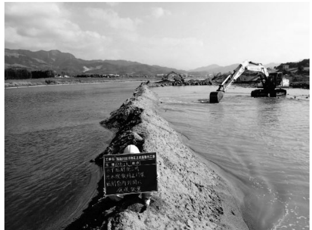
図-2 土堤内先行掘削
