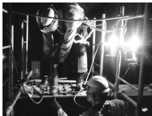
図-4 ピン圧入機械使用状況
