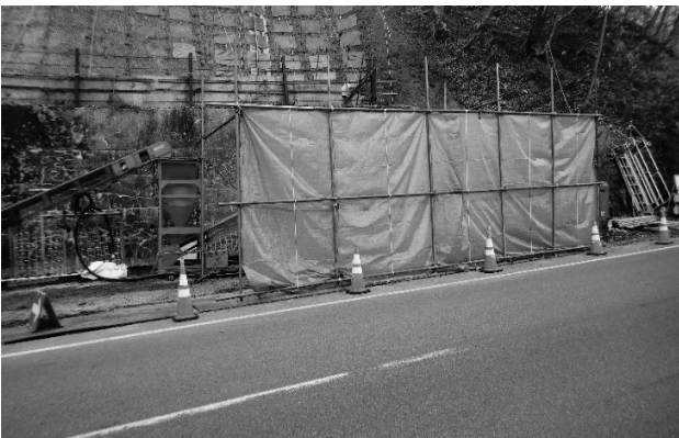
図-4 飛散防止シート設置
