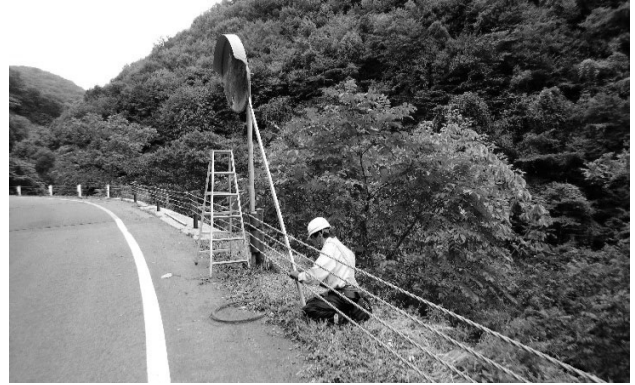
図-5 カーブミラー設置
