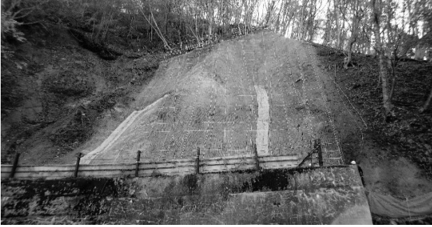
図-2 吸出防止材敷設
