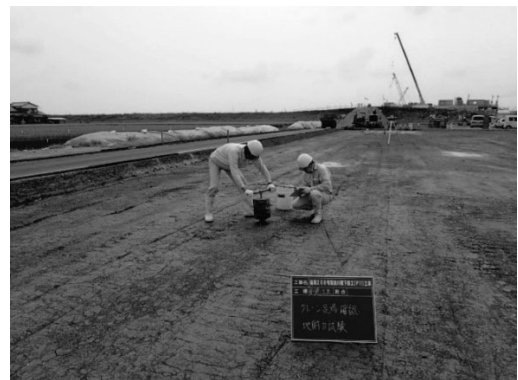
図-2 スウェーデン式サウンディング試験
