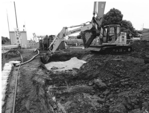
図-3 施工ヤード地盤改良
