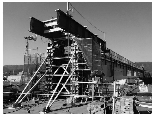
図-4 降下設備固定状況
